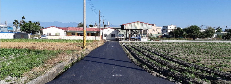
三重路 256 巷-ac 路面刨鋪
