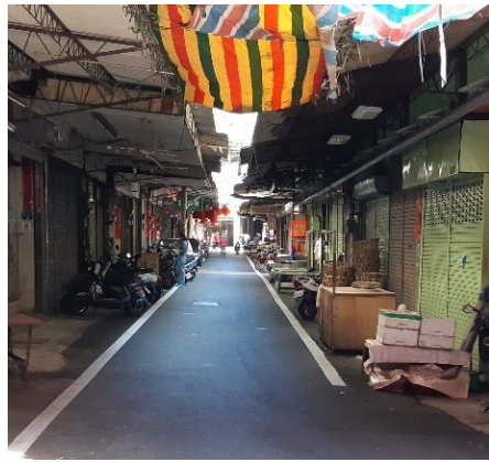
后里里復興街 99 巷-ac 路面刨鋪
